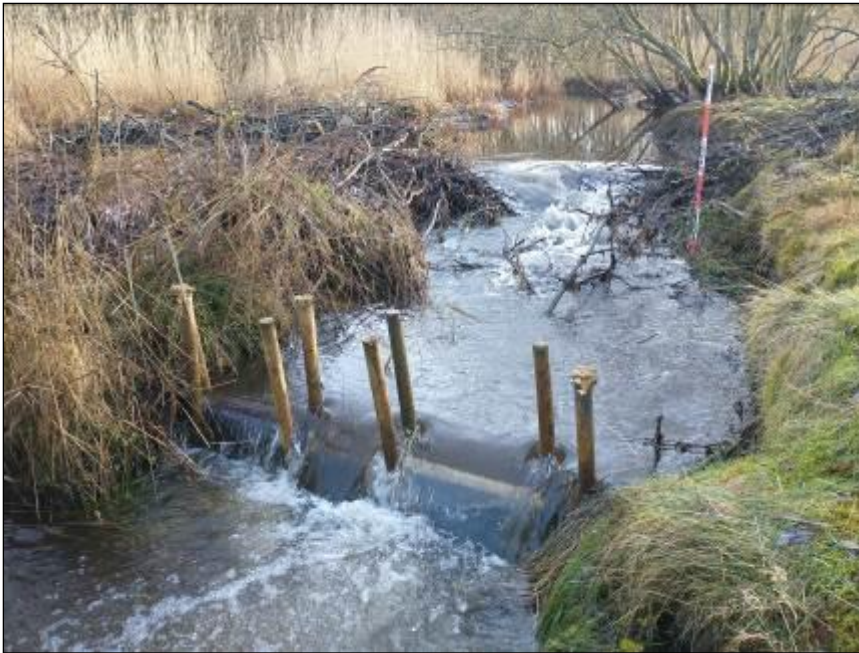
Afværgeforanstaltning ved bæverdæmning i Idom Å ved Ormstrup (foto: Jakob Larsen, 16. december 2021)
