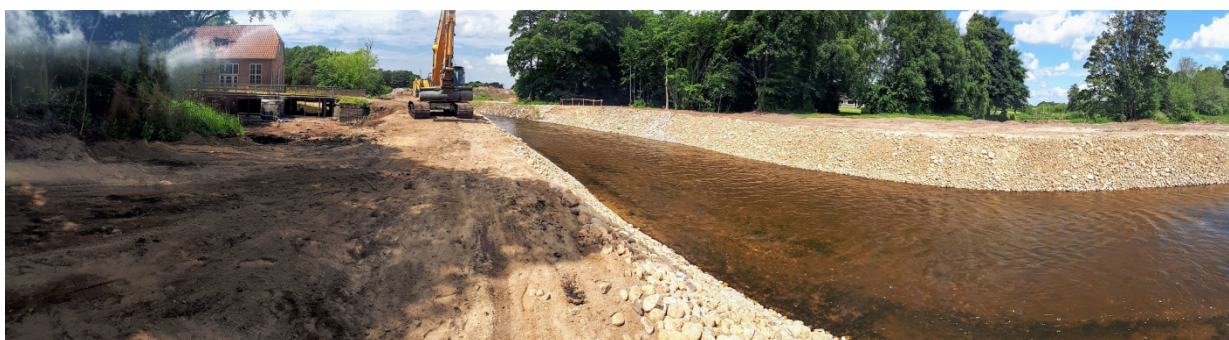
Fisk og smådyr har igen fri passage ved Jedsted Dambrug. På billedet ses den gamle opstemning til venstre og det nye stryg til højre. Et langt stryg med lavt fald genskaber naturlige forhold, så fiskene igen har fri adgang mellem gyde- og opvækstområder. Dambruget er nu et model 3-dambrug.
