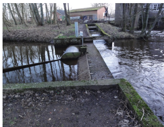
Opstemningen ved Utoft Dambrug og Ansager Mølle Dambrug spærrer for fiskenes frie adgang til egnede gyde- og opvækstområder i hhv. Grindsted Å og Ansager Å.
