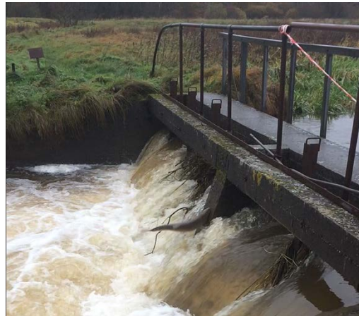
Rind Å forvirringen hindrer fri adgang til gydeområde i en stor del af Skjern Å-systemet og opgangsfisk springer ind i betonbygværket.
